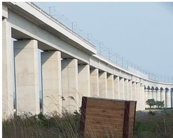
교량 측면 전경
